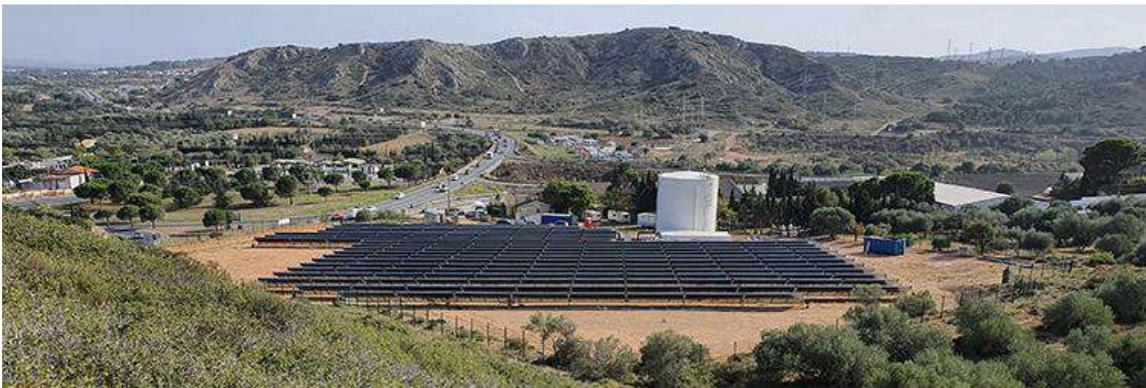
Fig. 1. Centrale solaire de Narbosol (capteurs solaires 3232 m<sup>2</sup> ; énergie fournie 2,3 GWh) (Narbonne)
